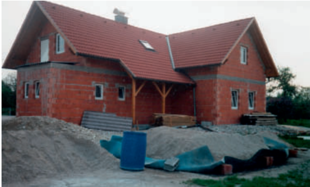
das Dach ist fertig
