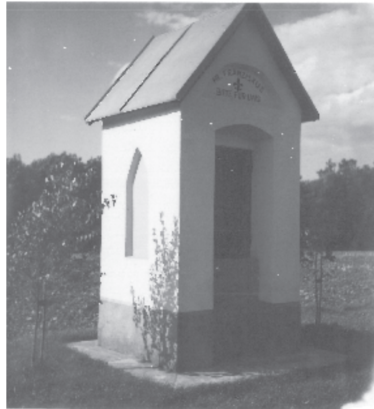
Die renovierte Kapelle im Oktober 1973
