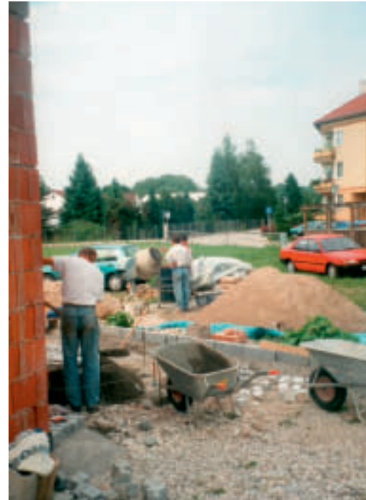
Kurt Aigner hat rund ums Haus gepflastert
