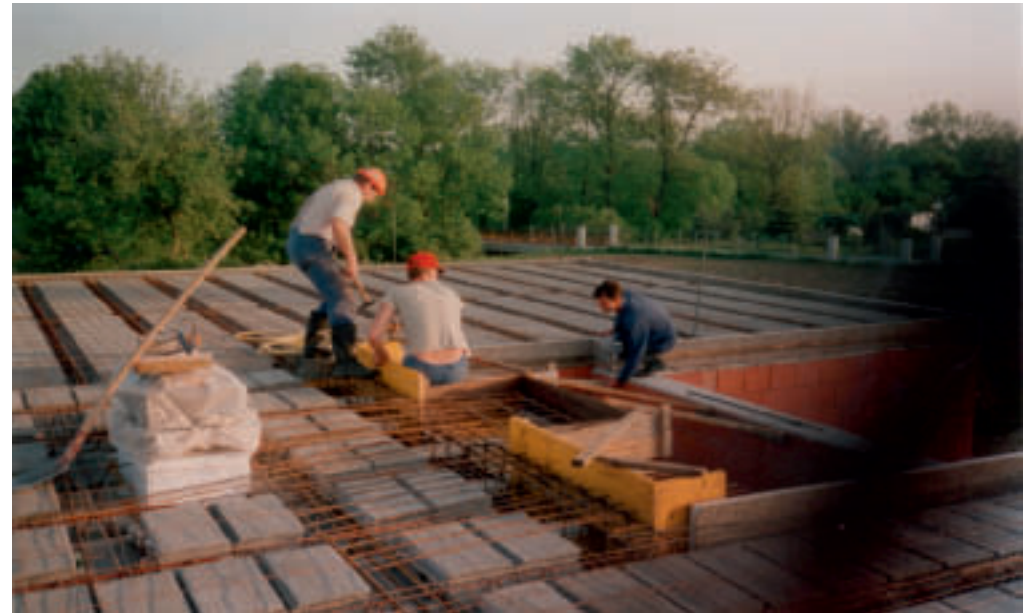
... lassen den Bau sichtbar voranschreiten
